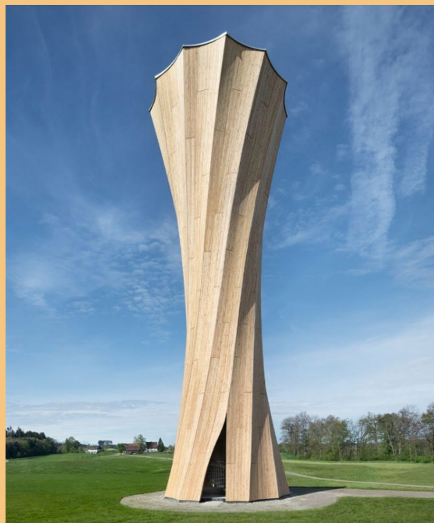
Figure 68: Cette tour panoramique de 22 m de haut est réalisée en éléments cintrés de bois lamellé-croisé. Le revêtement extérieur ventilé est composé de panneaux en mélèze massif de 20 mm d'épaisseur posés verticalement. (source: Blumer Lehmann)
