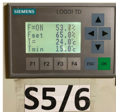
Abbildung 81: Steuerung Befeuchtung und Heizung in Produktionsbereich. (Quelle: Roth Burgdorf AG)
