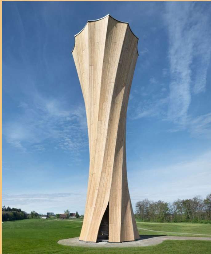
Abbildung 68: Der 22 Meter hohe Aussichtsturm ist mit Bauteilen aus gekrümmtem, kreuzweise verleimtem Holz konstruiert und mit vertikal angebrachten, 20 mm starken Massivholzpaletten aus Lärche hinterlüftet verkleidet. (Quelle: Blumer Lehmann)
