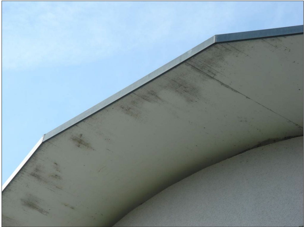
Abbildung 46: Sekundärbläue (Anstrichbläue) an einem Vordach durch dauernde Kondensatbildung im Herbst und Winter (Quelle: Kolb)
