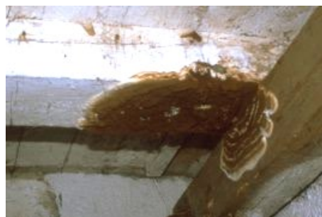
Infestation du plafond de la cave en raison d'une conduite d'eau non étanche
