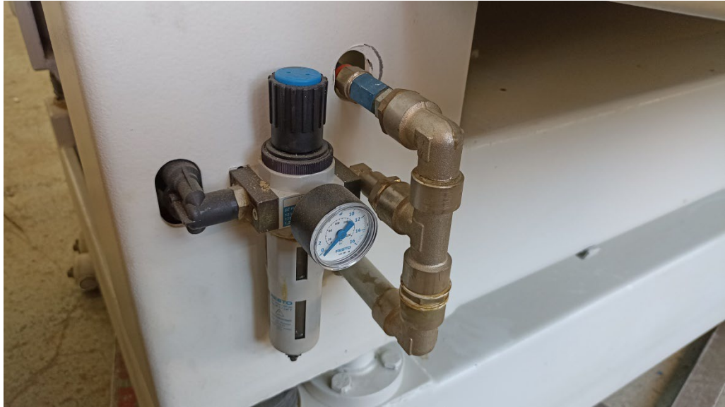
Abbildung 80: Druckreduzierventil (Quelle: Näf Service und Maschinen AG)
