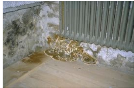
Befall an Innenwand infolge eindringender Feuchtigkeit
