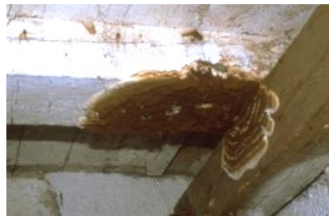
Befall an Kellerdecke aufgrund einer undichten Wasserleitung
