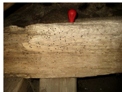
Image des dégâts dans une poutre de chêne
