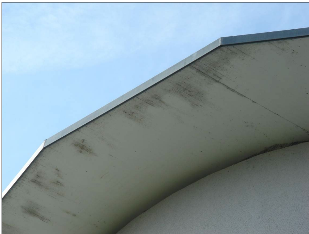
Figure 46 : Bleuissement secondaire (bleuissement de la peinture) sur un avant-toit dû à la formation permanente de condensation en automne et en hiver. (source : Kolb)
