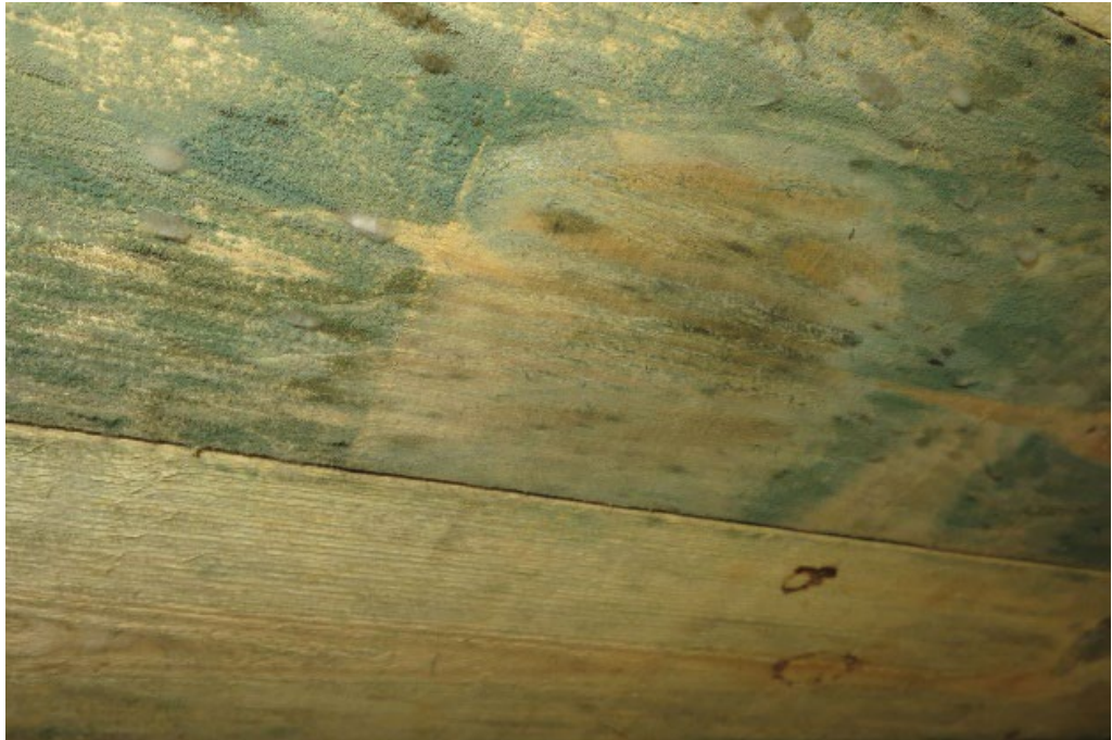
Abbildung 43: Schimmelpilze auf Dachschalung (Quelle: advisan.net)
