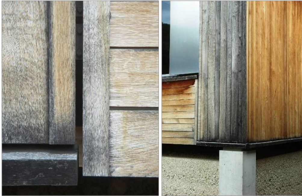
Abbildung 189: Bläuepilzbefall an der Fassade des Schulgebäudes der BFH-AHB Biel (Quelle: Stalder)
