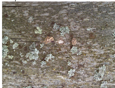
Attaque de lenzites sur la structure porteuse d'une tour d'observation (Lothurm, Macolin)
