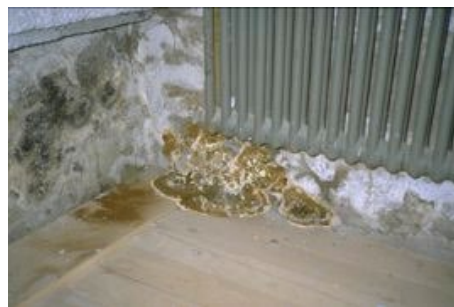
Attaque sur un mur intérieur suite à une infiltration d'humidité
