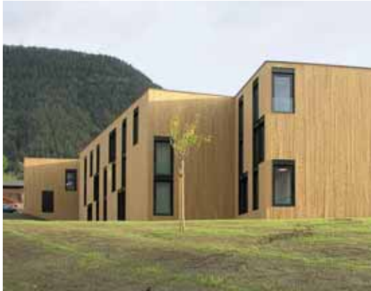
Figur 132: Vordachlose Architektur mit druckimprägnierter Fichtenschalung
