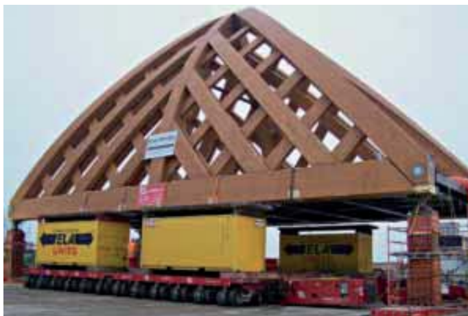
Soll 80 Jahre halten: Die Holzwerkbrücke von Sneek, die aus acetyliertem Holz gebaut wurde.
