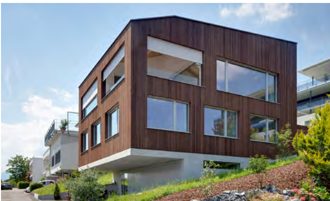
Fassade Tanne, druckimprägniert, KDS chromfrei Braun, geölt
