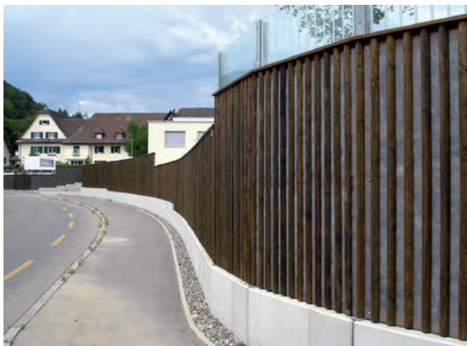
Lärmschutzwandsystem mit druckimprägniertem Holz
