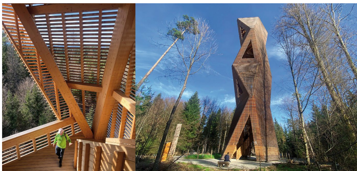
Construction de l'année 2022 : la tour Hardwald illustre de manière exemplaire les multiples possibilités d'utilisation du bois suisse local.
