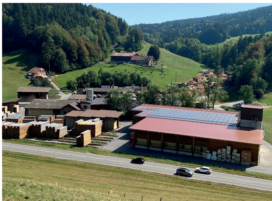
↑ La scierie Yerly SA est située en dehors du hameau de Treyvaux, à proximité du Lac de la Gruyère.
